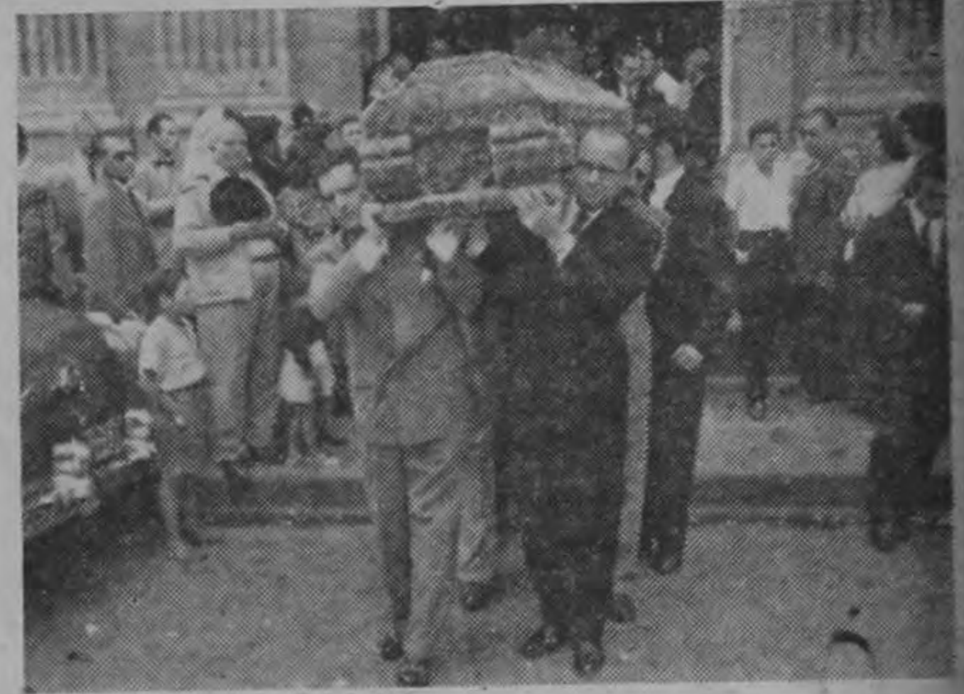
Transportando los restos del Capitán Jorge Morales.—(Foto Arévalo).
